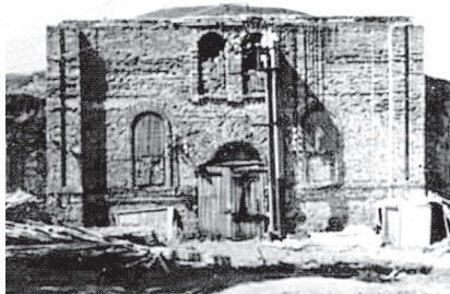
Разрушенная Преображенская церковь
